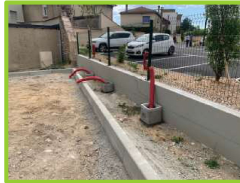
Pose du réseau souterrain pour places ouvertes avec Totem
