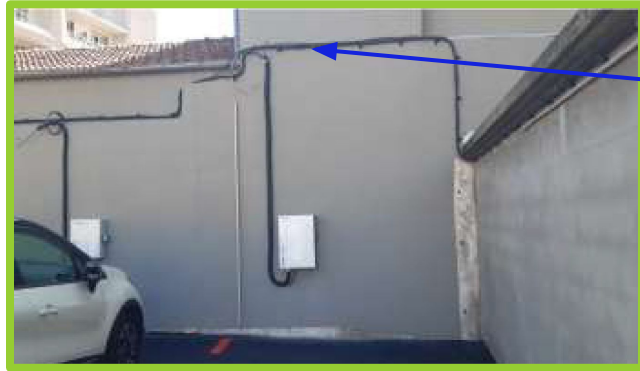
Pose du réseau sur façade
