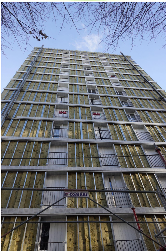
ITE + bardage + changement garde corps (Gentilly)
