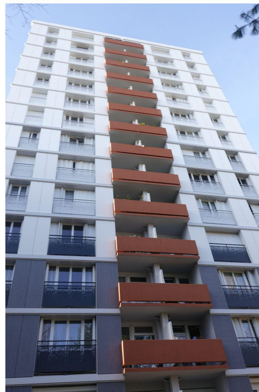
ITE + bardage + changement garde corps (Gentilly)
