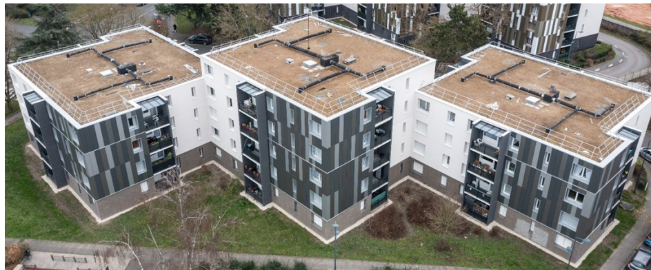
5. Façade + étanchéité de toiture
