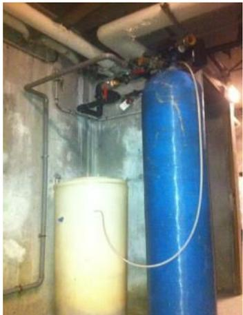
Présence d'un adoucisseur non-raccordé ayant fonctionné jusqu'à la livraison par la ville d'une eau moins « dure » en 2017.
