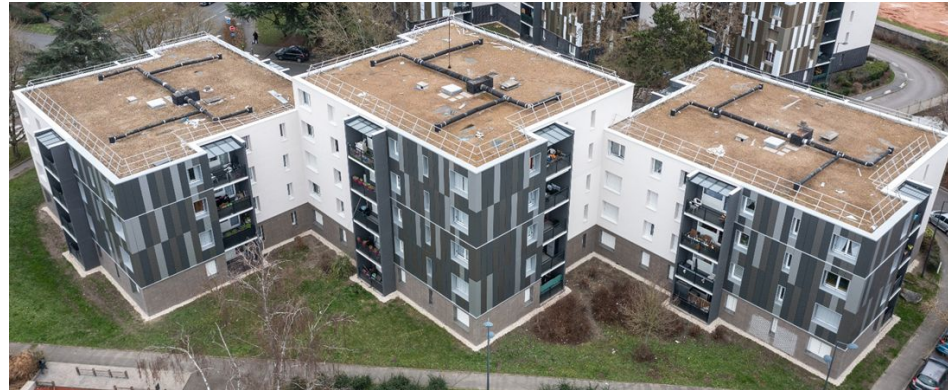
5. Façade + étanchéité de toiture
