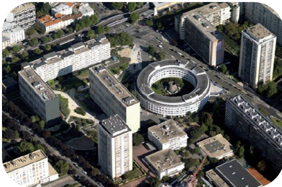
Immeuble de logements collectifs (13 ème arrondissement)
