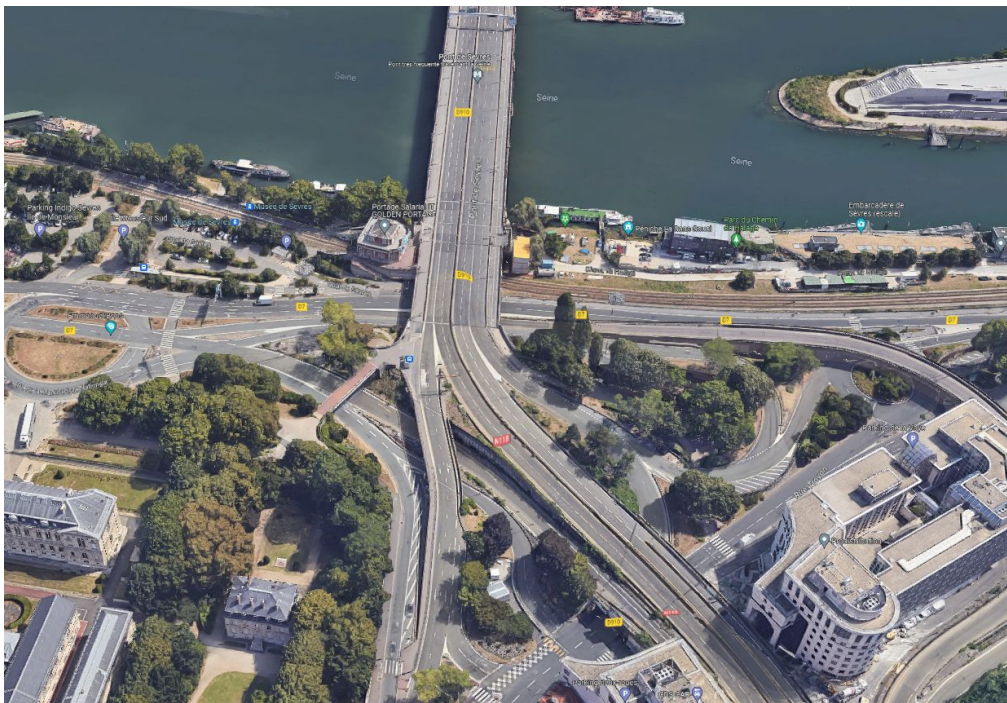
Pont de Sèvres
