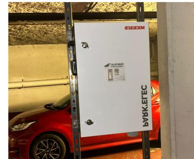
**Coffret avec fixation au sol et au plafond**
