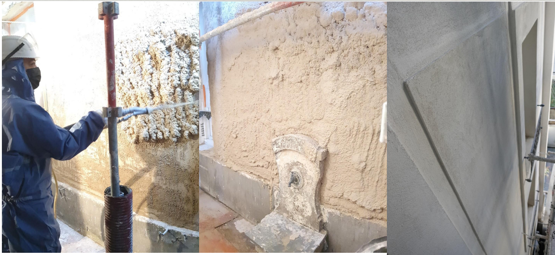
PROJECTION ENDUIT CONSTITUÉ DE BILLES AEROGELS
