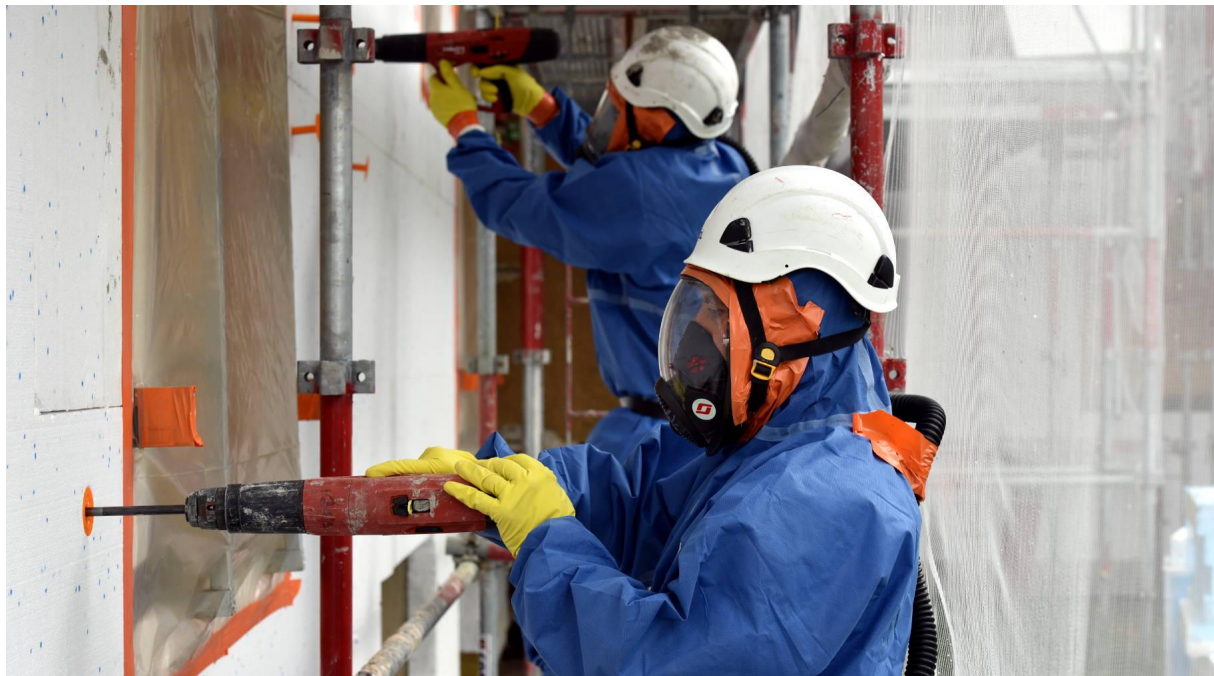
Chevillage par pisto-scellement
