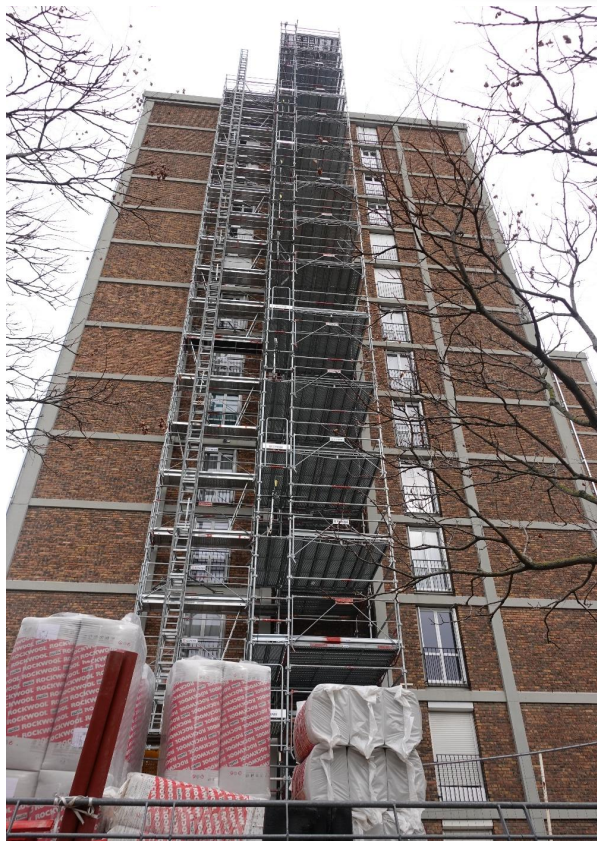
Pose Bardage EQUITONE + Changements des Garde Corps
