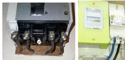
Présence d'un seul câble par borne dans l'AGCP départ client
