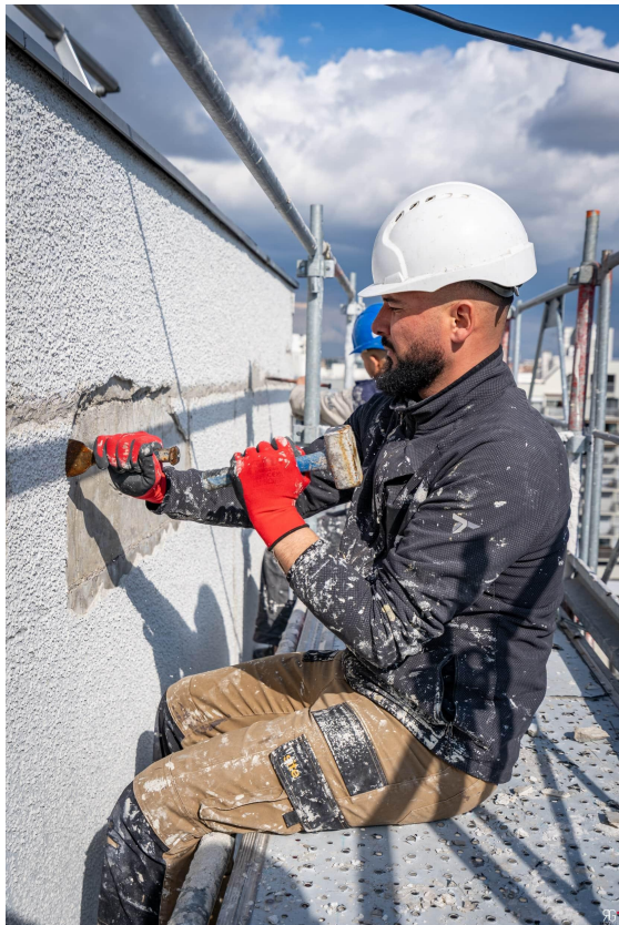
Purge des parties mal adhérentes après sondages
